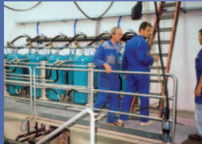
Erste Zentralfilteranlage für Werkzeugschleifmaschinen (HM) bei Prototyp Werke (ca. 1000 l/min, Tankvolumen 30.000 l)
